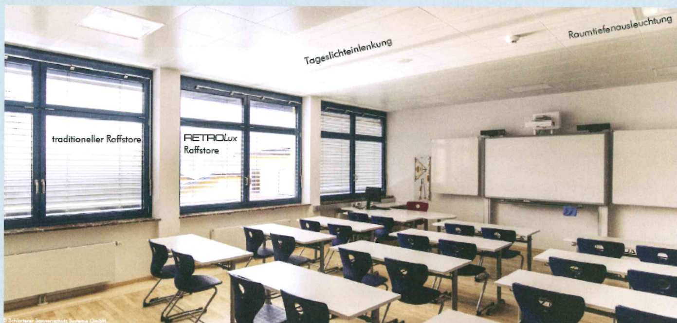
Im Funktionsvergleich: RETROlux Sonnenschutz mit Lichtlenkung in der Mitte – rechts und links daneben traditioneller Raffstore ohne Lichtlenkung. Foto: Schlotter Sonnenschutzsysteme GmbH
